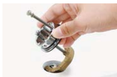
①上面施工工具をカウンターの取付穴に通します。
