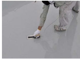
防水材の施工(2層目)
