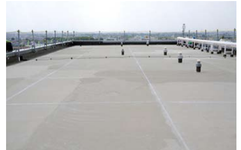
下地処理完了
