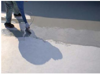
防水材の施工(1層目)
